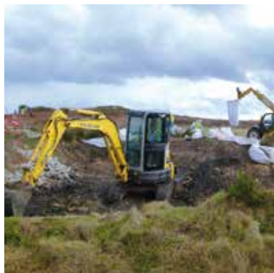
Excavation de sols pollués ©ADEME
